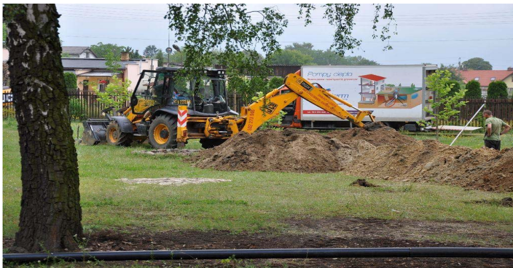
Figura 5. Installazione del tubo orizzontale
