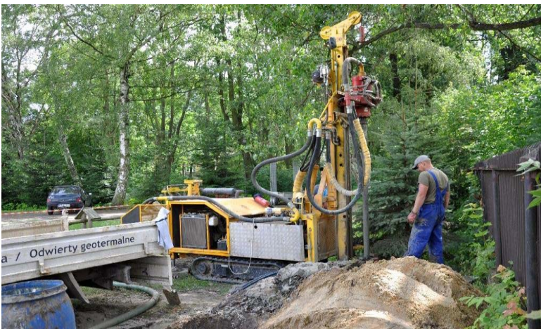
Figura 4. Trivellazione dei fori
