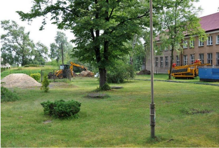
Figura 3. Spazio libero per lo scavo, con caratteristiche geologiche e idrologiche adatte alla perforazione
