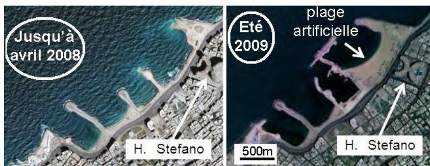
Fig. 19- Exemple de renforcement des ouvrages de défense de la côte et création de nouveaux espaces récréatifs et de plages par alimentation artificielle dans la partie nord-est d'Alexandrie (images Google de différentes dates).
