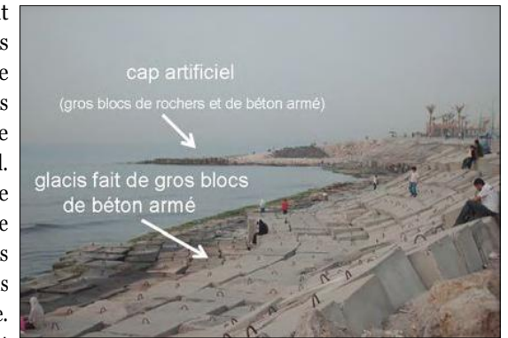
Fig. 11- Les grandes accumulations de gros blocs de rochers ou en béton sous la forme de glacis ou d'épis parfois volumineux et massifs à la manière de vrais caps: un paysage devenu commun à de longs segments du littoral alexandrin, surtout à la hauteur du fort de Qait Bey et le long de la Corniche entre Selselet et Sidi Bishr. Ici, la situation à la hauteur de Cleopatra Beach.
