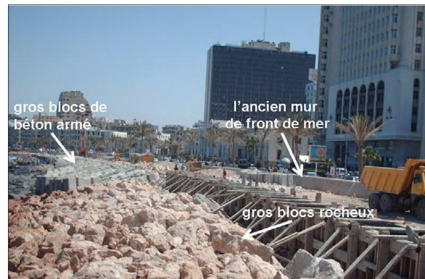
Fig. 16- Travaux d'extension de la promenade de bord de mer dans le centre d'Alexandrie (mars 2008)
