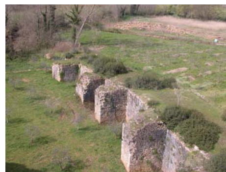
Resti della diga sul fiume Bruna
