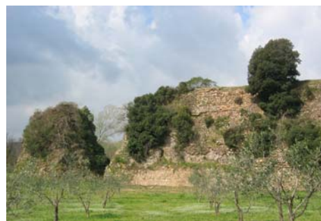
Resti della diga sul fiume Bruna
