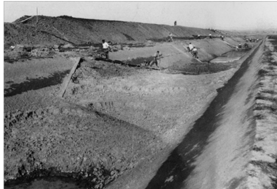
Scavo dei canali
